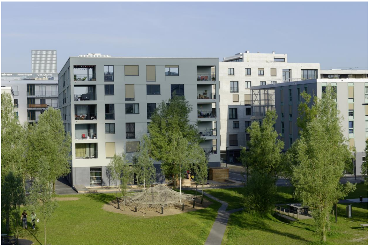
Genossenschaftsstrasse 11 et aire de jeux près du pavillon scolaire. Photo: Ursula Meisser
