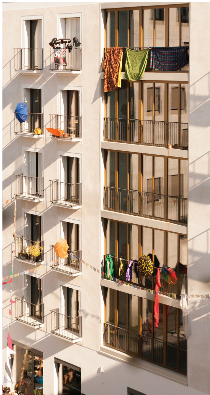
Tous les bâtiments du Hunziker Areal sont équipés d'une isolation de première classe conforme à la norme Minergie-P. Photo : Coopérative « mehr als wohnen »
