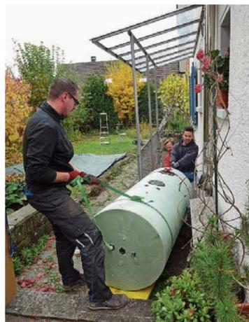
Präzisionsarbeit: Die Monteure bauen den 500-Liter-Solarspeicher ein.
