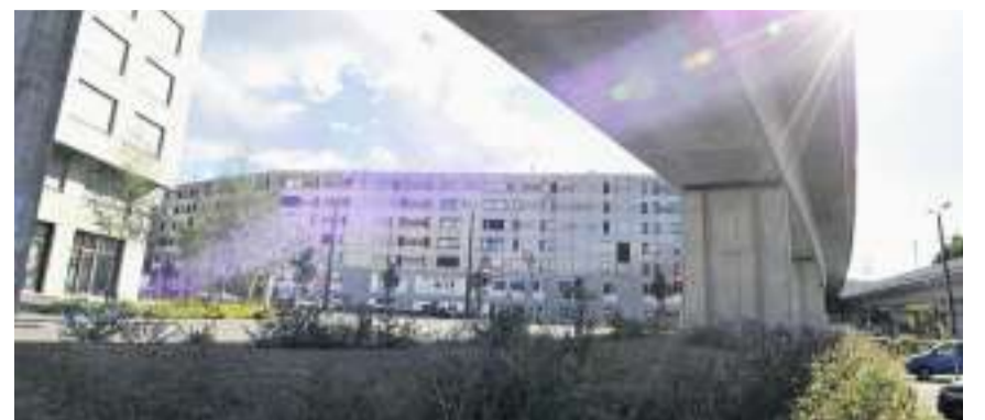
Bis zu 10 Personen teilen sich eine Grosswohnung auf dem Zwicky-Areal.
