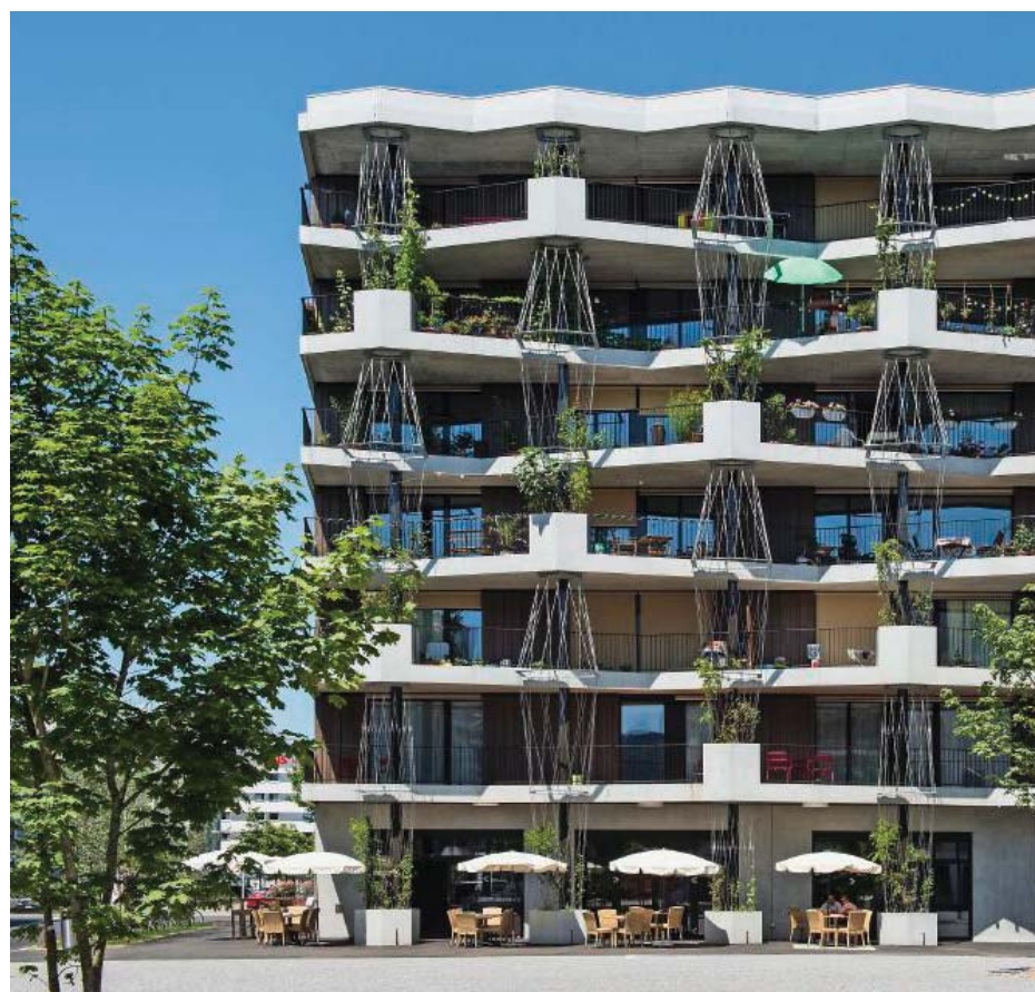
Kletterpflanzen an Chromstahlseilen sollen einst für eine grüne Fassade sorgen.
