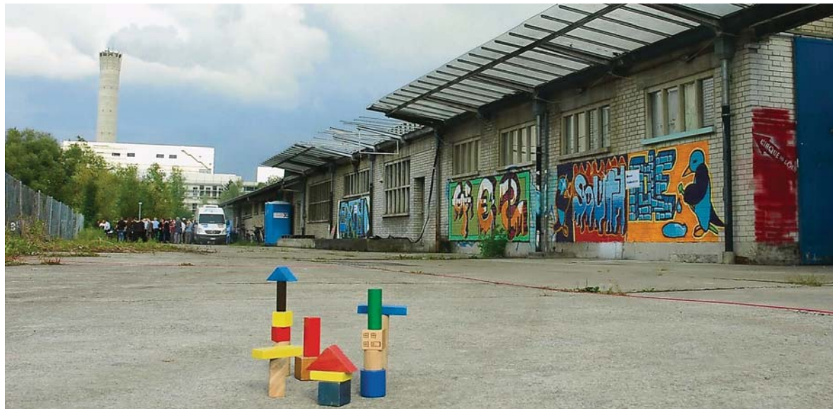
Ein Vierteljahrhundert lang lag das Hunzikerareal brach. Jetzt entsteht hier ein zukunftsweisendes Quartier.
