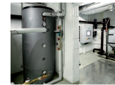
Schichtenspeicher mit Pontos AquaCycle im Hintergrund
