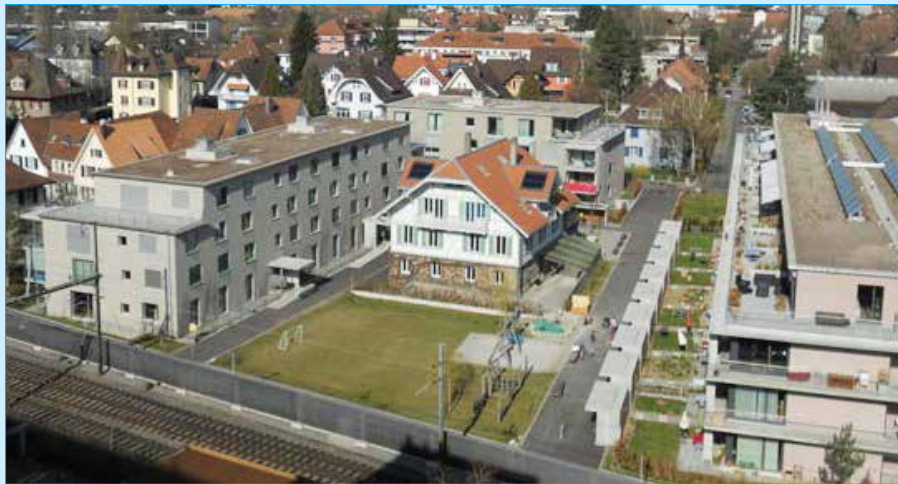
Ansicht der Siedlung Burgunder in Bümpliz: eine der ersten Wohnsiedlungen für autofreie Mieter, die fast ohne eigene Parkplätze auskommen.
