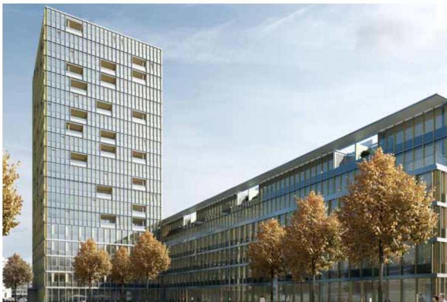
Ansichten aus Zürich-Leutschenbach und Umgebung II: neues Wohn- und Business-Center Leutschentower.
